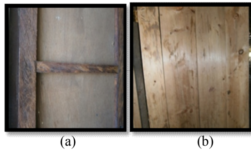
Gambar 6. Rumah masyarakat di bangun menggunakan Kayu Damar (a) Papan dari kayu Damar (b) Balok dari kayu Damar
