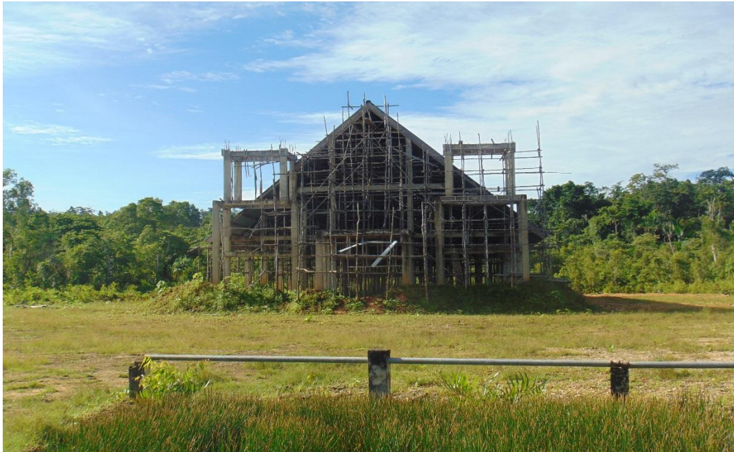
Gedung Gereja Baru Salafen (S1° 49.766' E129° 50.336')
