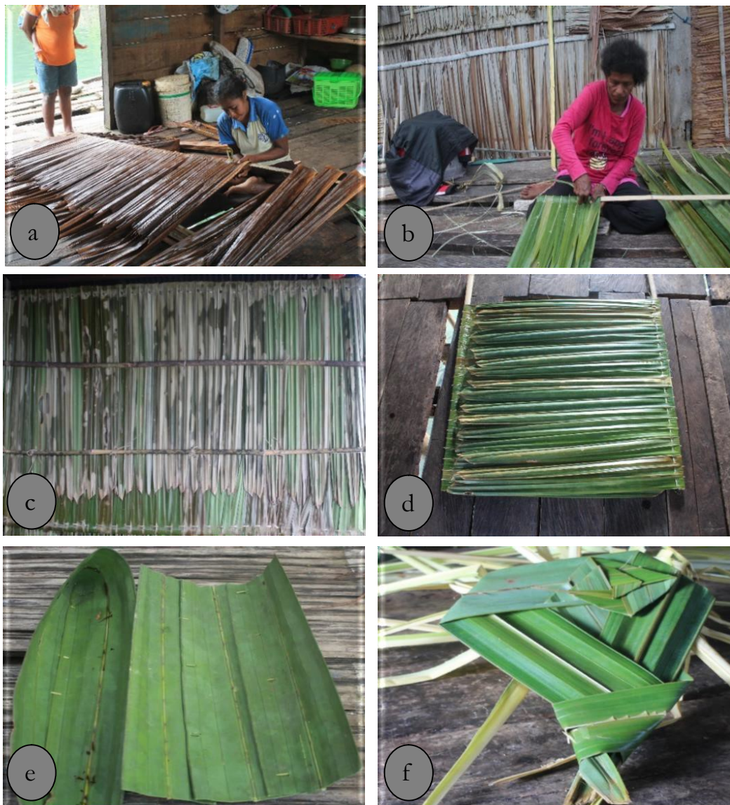
Gambar 6. Bentuk pemanfaatan daun nipah; a). proses menjahit atap rumah, b). proses menjahit dinding rumah, c). dinding rumah yang sudah jadi, d). dinding rumah ukuran kecil (jendela rumah), e). pembungkus makanan, f). kipas api.
