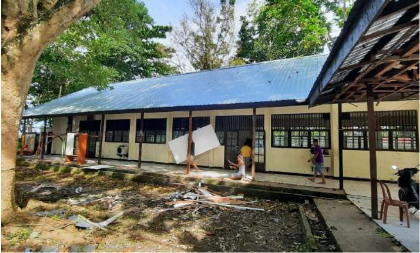
Bangunan gedung eks. BLK Manokwari
