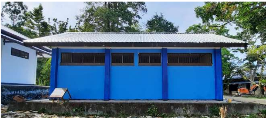
Bangunan gedung eks. BLK Manokwari
