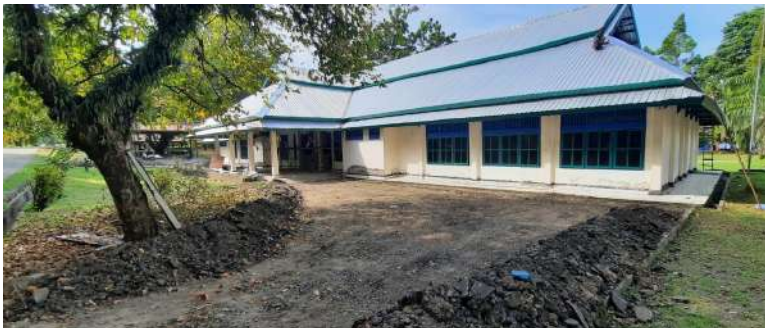
Beberapa bangunan dan jalan area gedung eks. BLK Manokwari yang sedang direnovasi
