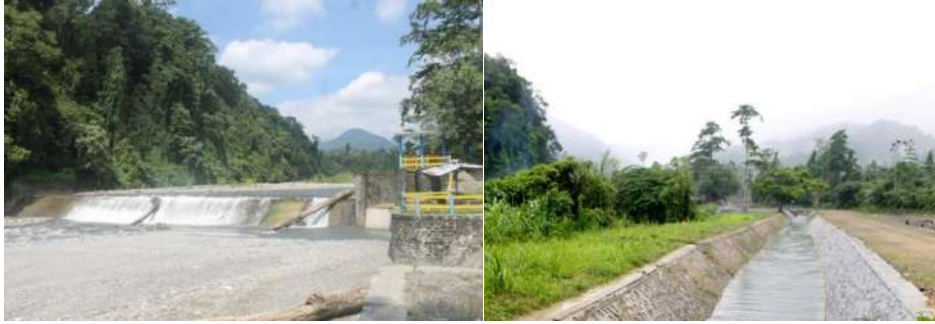
Gambar 15-12 Kiri, bendungan rendah ( weir ) dan kanan, saluran irigasi untuk mengairi areal persawahan di Sungai Aimasi (Foto: E. Manangkalangi 2017)
