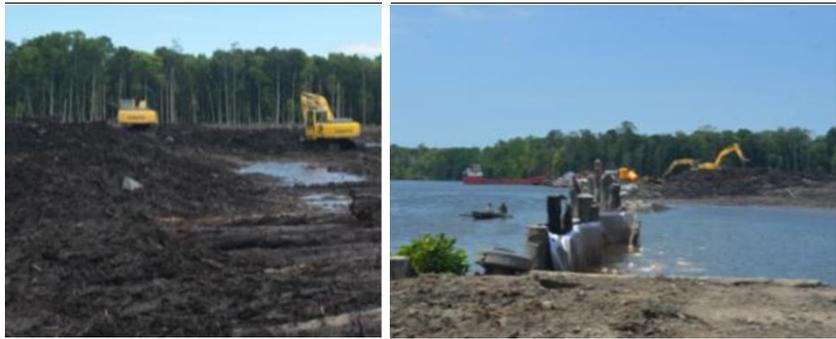
Gambar 4.34. Reklamasi Lahan dengan Menggunakan Tractor dan Penutupan Kanal
