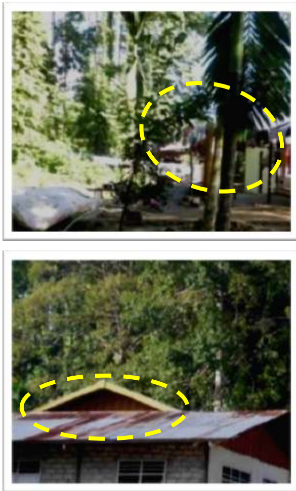
Gambar 24. Pembangunan Pemukiman di dalam TWA Gunung Meja
