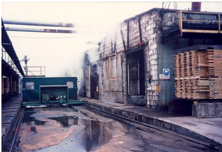
Gambar 15.1. Kilang pengeringan kayu gergajian menggunakan energi uap ( steam )
