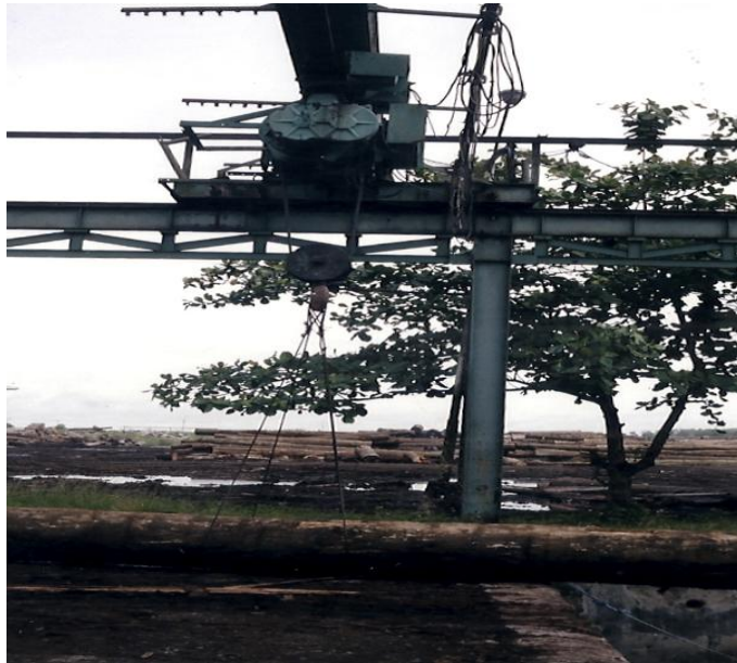
Gambar 8.5. Salah satu hoist crane yang sedang memindahkan kayu log dari log pond ke kereta kayu log
