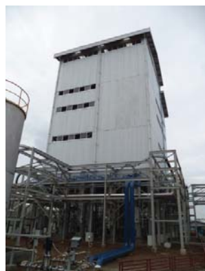
Lokasi: Pabrik Alphapinene/PPCI di Pemalang, Jawa Tengah
